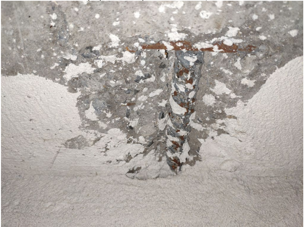
Фото 96. Контрольное вскрытие системы рабочего армирования многопустотных плит перекрытия и покрытия в осях 2-10/Б-Д
