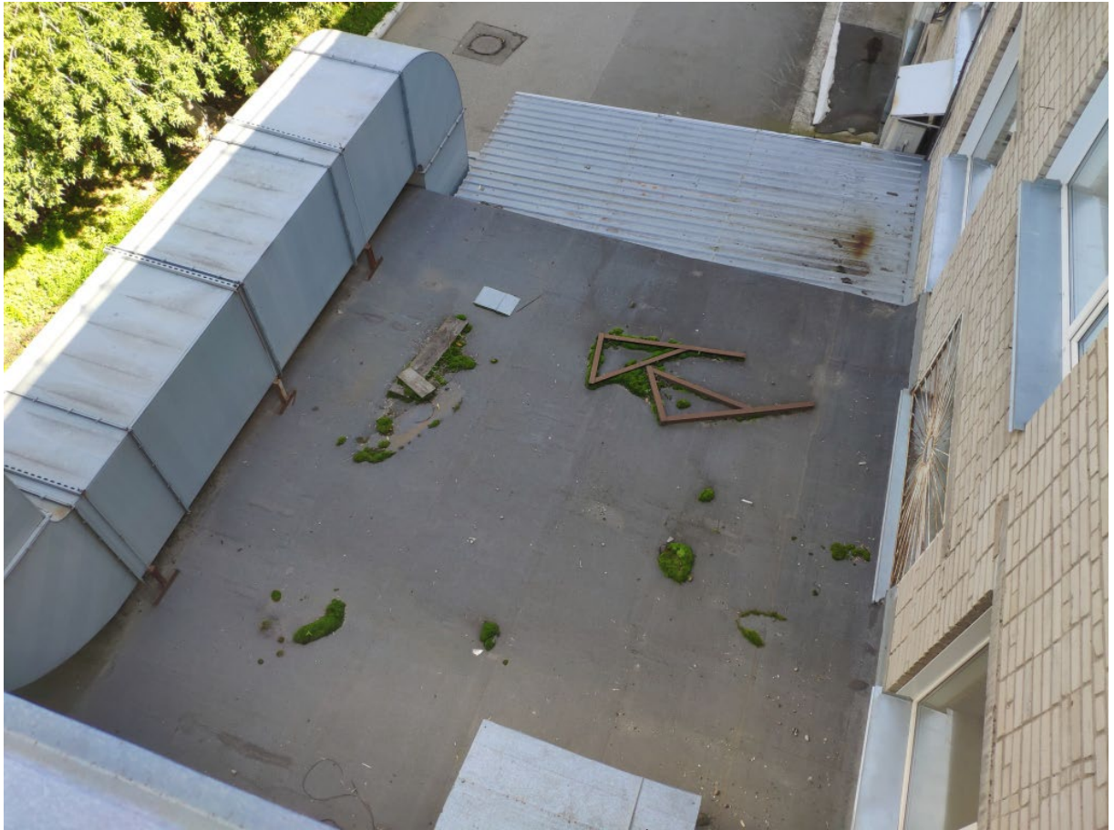
Фото 51. Кровля в осях 3-5/Д-Е. Общий вид
