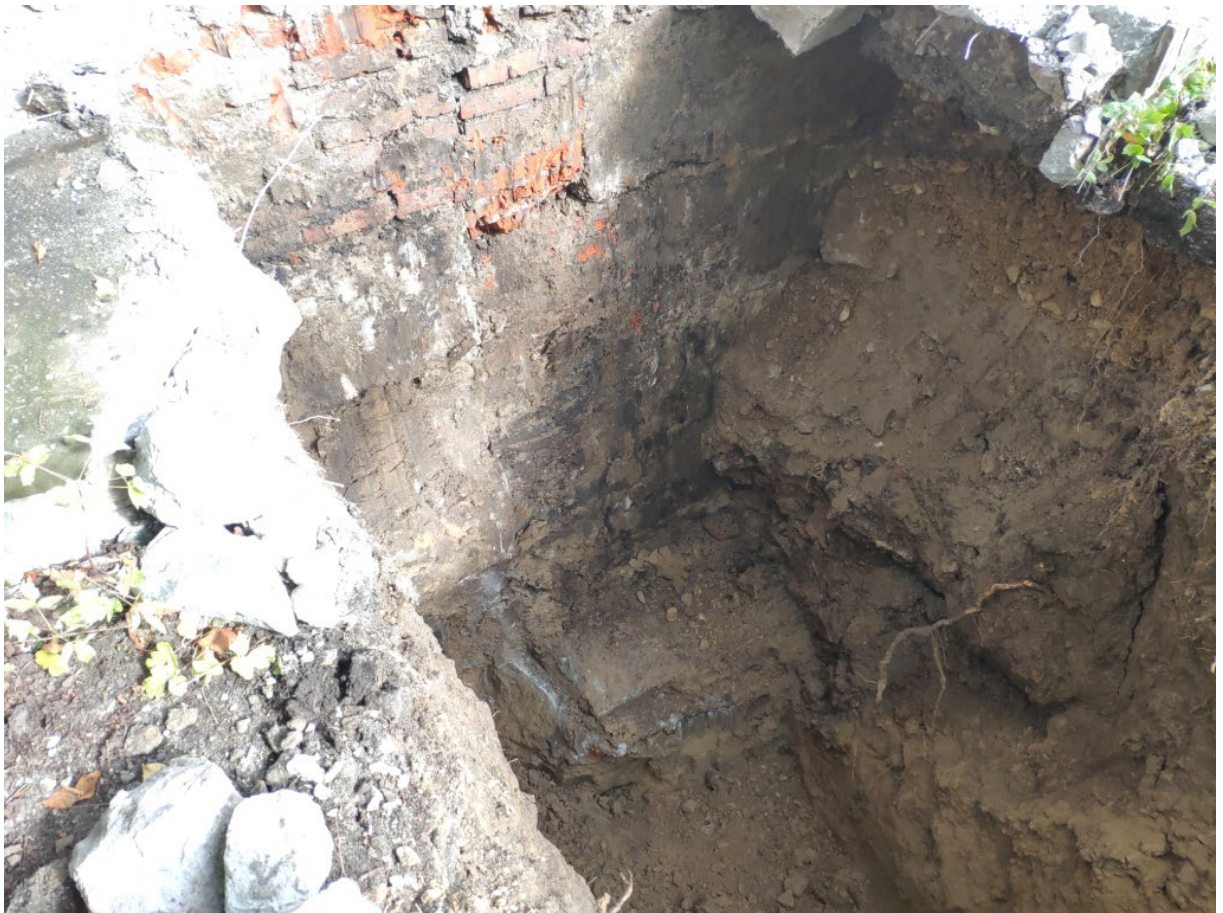
Фото 150. Контрольное вскрытие конструкций фундаментов (шурфление) в осях 8/Б
