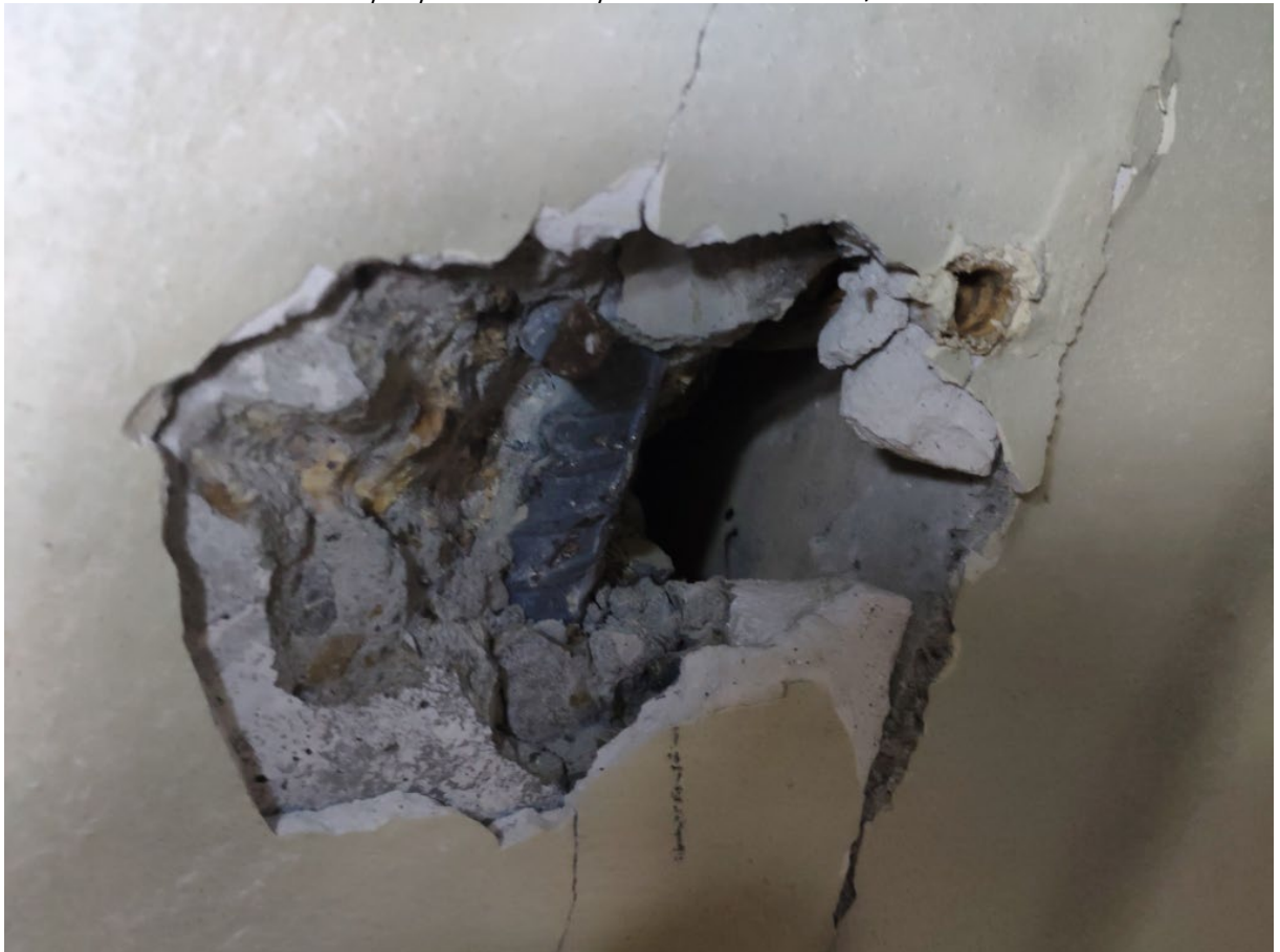
Фото 102. Контрольное вскрытие системы рабочего армирования многоспустотных плит перекрытия и покрытия в осях 2-10/Б-Д
