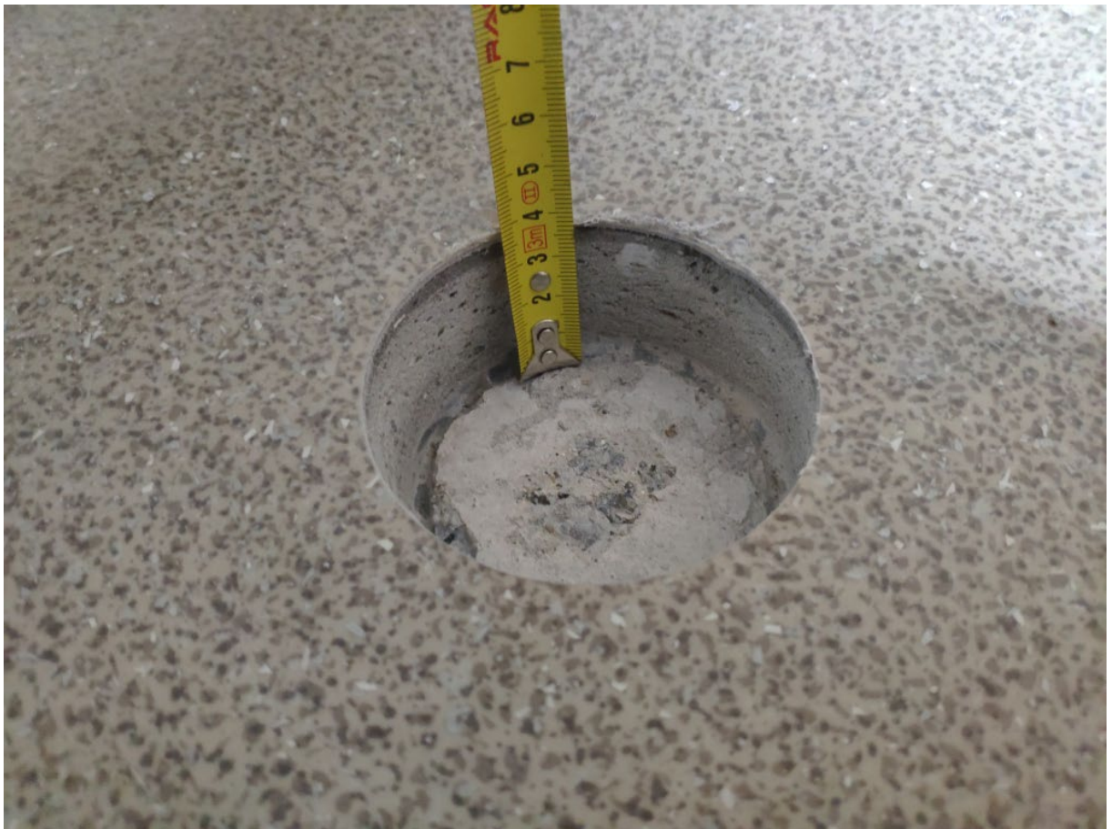
Фото 122. Контрольное вскрытие конструкций пола №2.2 1-го этажа в осях 5-6/Б-В
