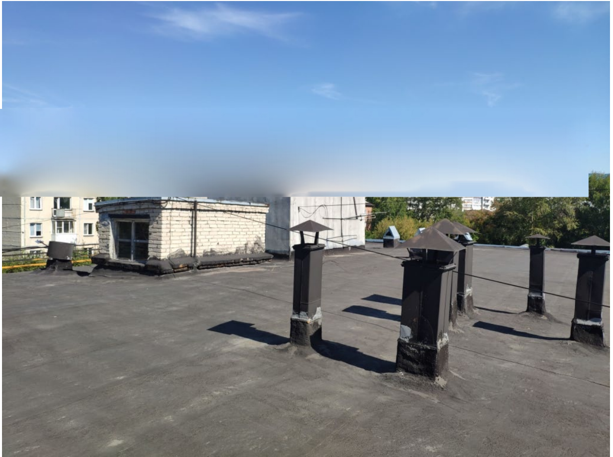
Фото 59. Кровля в осях 6-10/Б-Д. Помещений выхода на кровлю и машинного отделения лифтовой шахты. Общий вид
