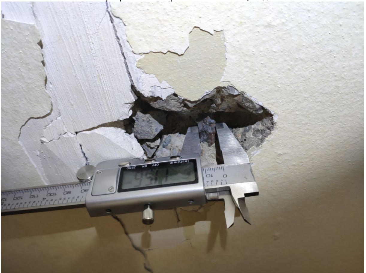
Фото 104. Контрольное вскрытие системы рабочего армирования многопустотных плит перекрытия и покрытия в осях 2-10/Б-Д
