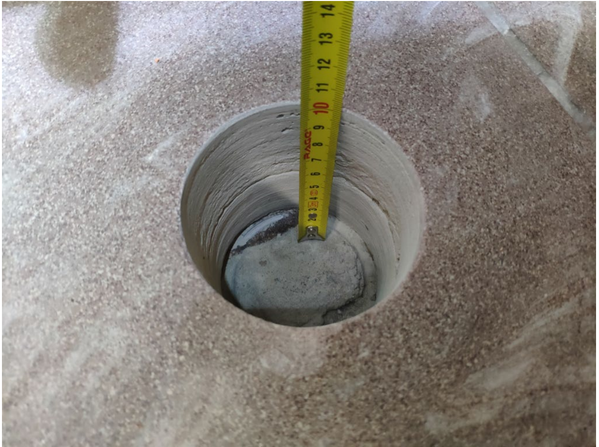
Фото 123. Контрольное вскрытие конструкций пола №2.1 1-го этажа в осях 5-6/В-Г
