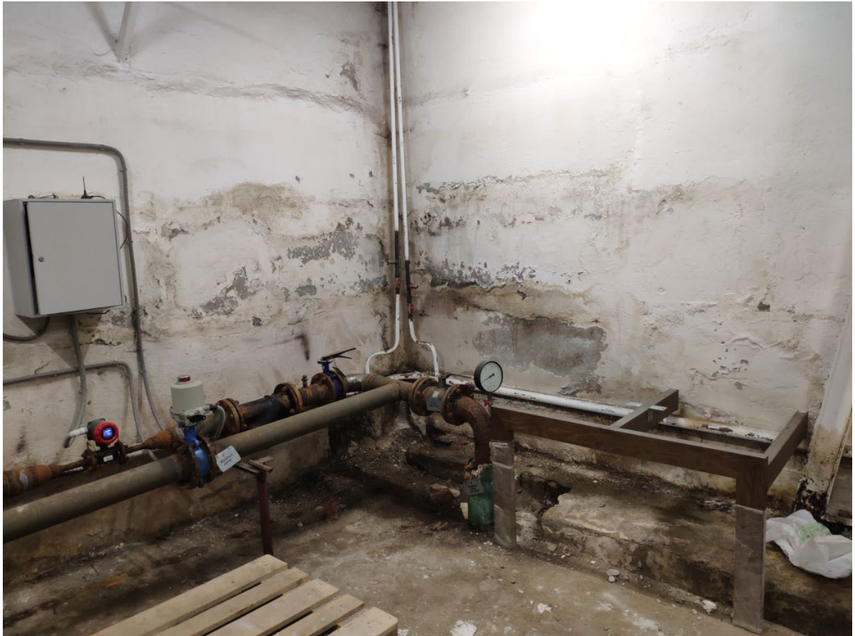
Фото 83. Следы замачивания и высолы и разрушение отделочного штукатурного слоя стен подвала стен подвала в осях 3-5/А-В
