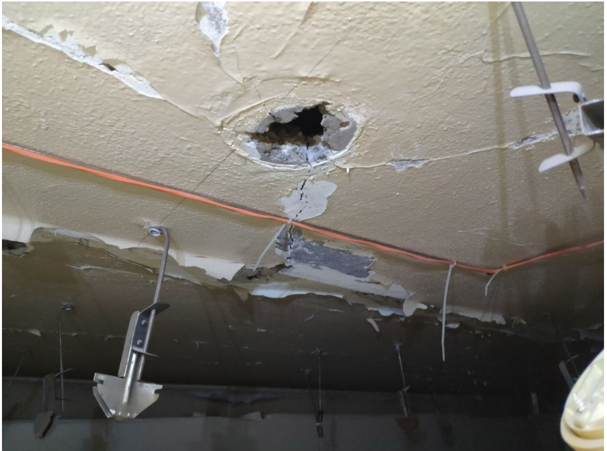
Фото 124. Нормальные трещины в плите перекрытия 2-го этажа шириной раскрытия до 1,5мм
