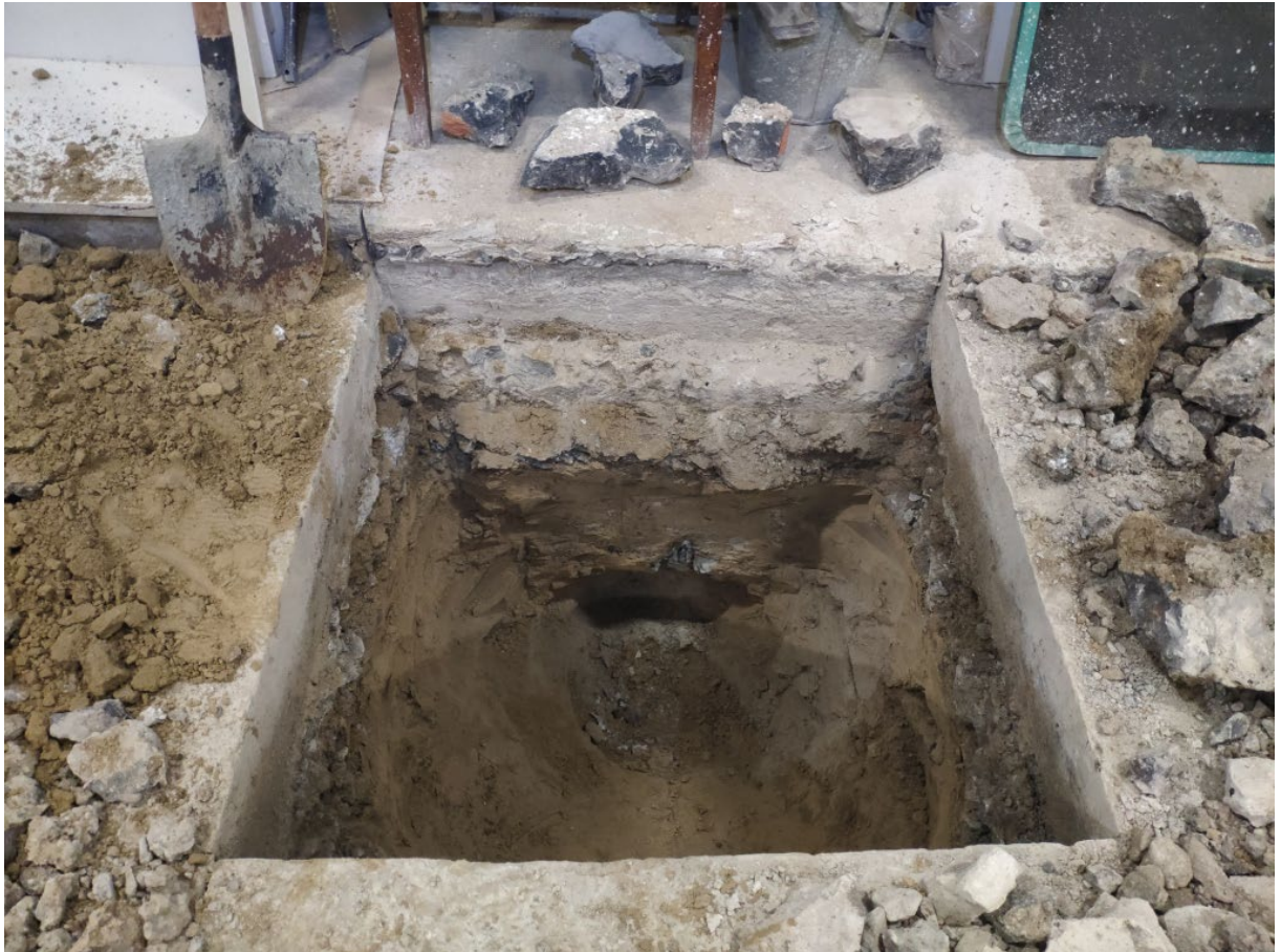
Фото 143. Контрольное вскрытие конструкций фундаментов (шурфление) в осях 8-9/В
