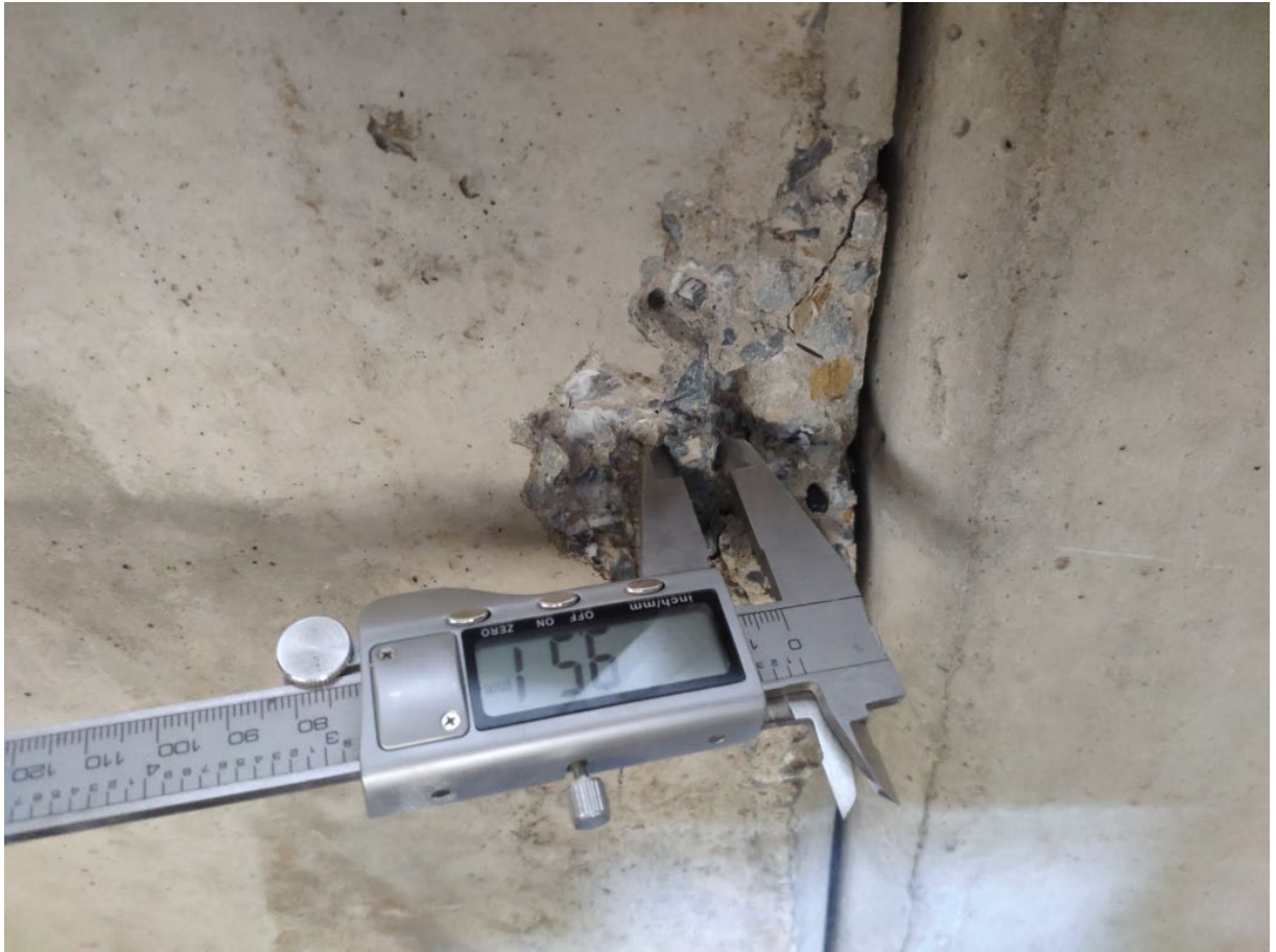
Фото 101. Контрольное вскрытие системы рабочего армирования многоспустотных плит перекрытия и покрытия в осях 2-10/Б-Д
