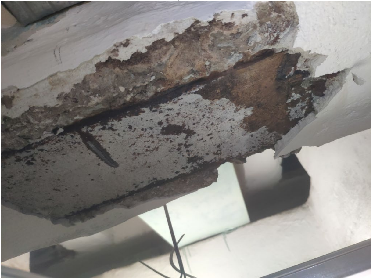
Фото 156. Контрольное вскрытие балки стального балочного перекрытия подвала в осях 5-7/Б-В
