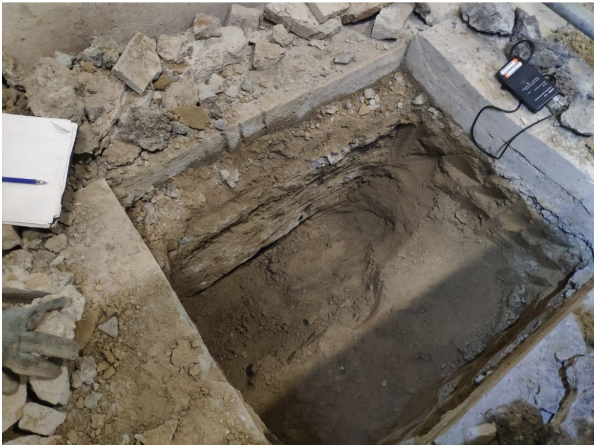
Фото 14.2. Контрольное вскрытие конструкций фундаментов (шурфление) в осях 4-5/В
