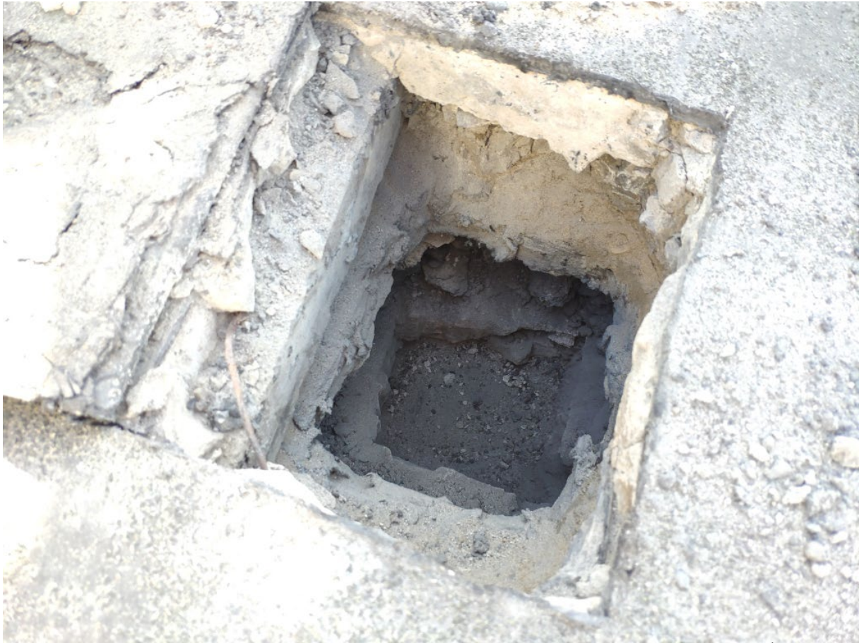
Фото 14.7. Контрольное вскрытие конструкций кровли №5.1 в осях 2-3/Д-Е
