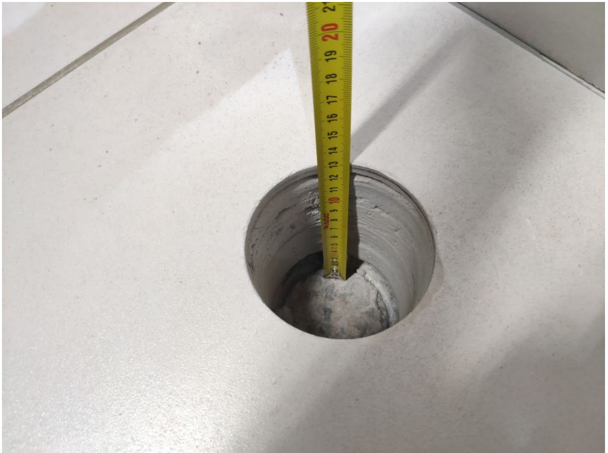
Фото 121. Контрольное вскрытие конструкций пола №2.3 1-го этажа в осях 8-9/В-Г
