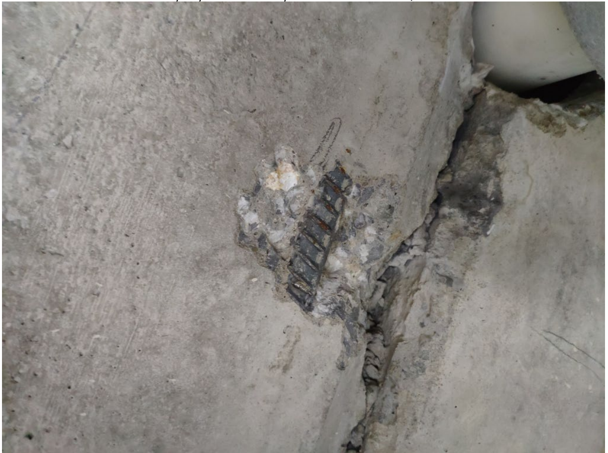
Фото 94. Контрольное вскрытие системы рабочего армирования многопустотных плит перекрытия и покрытия в осях 2-10/Б-Д
