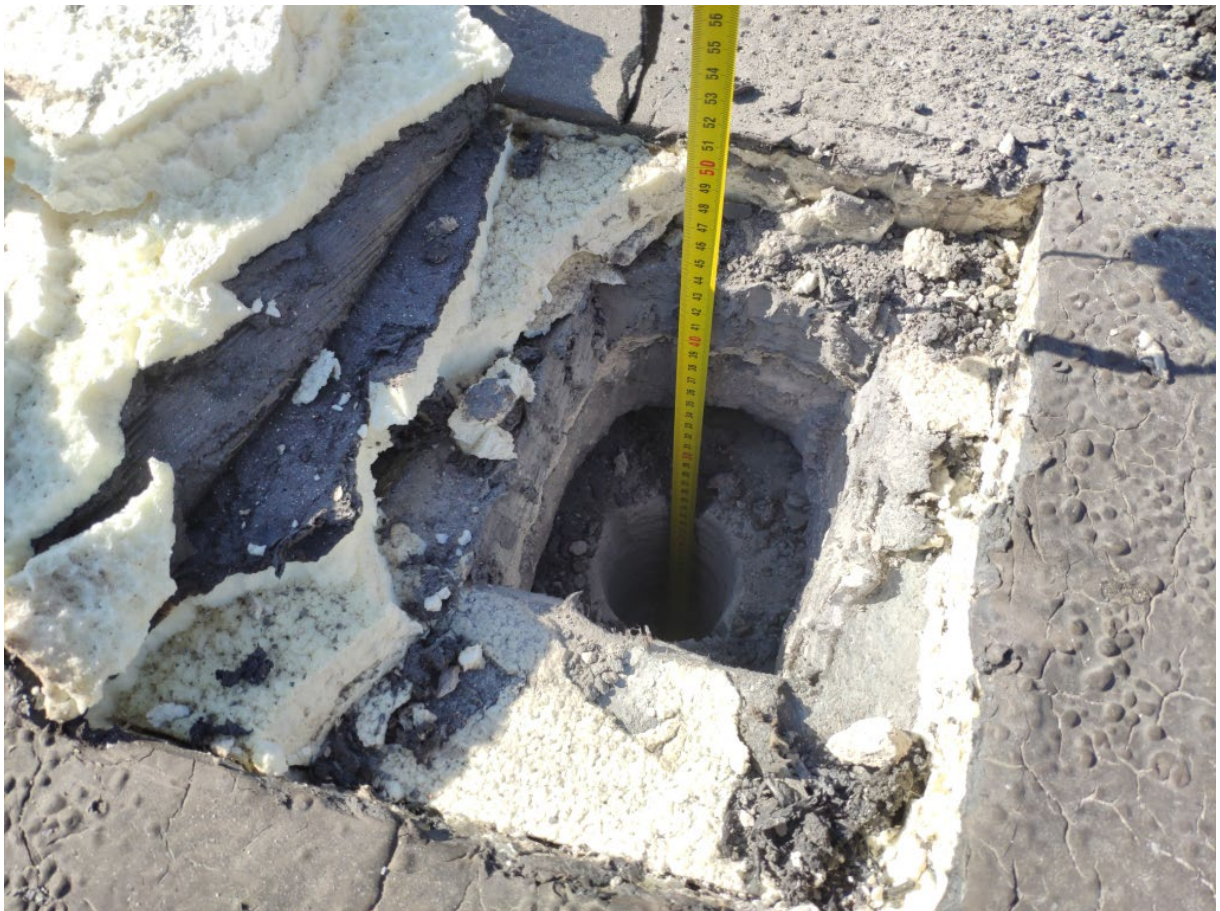
Фото 146. Контрольное вскрытие конструкций кровли №5.2 в осях 3-5/Г-Д
