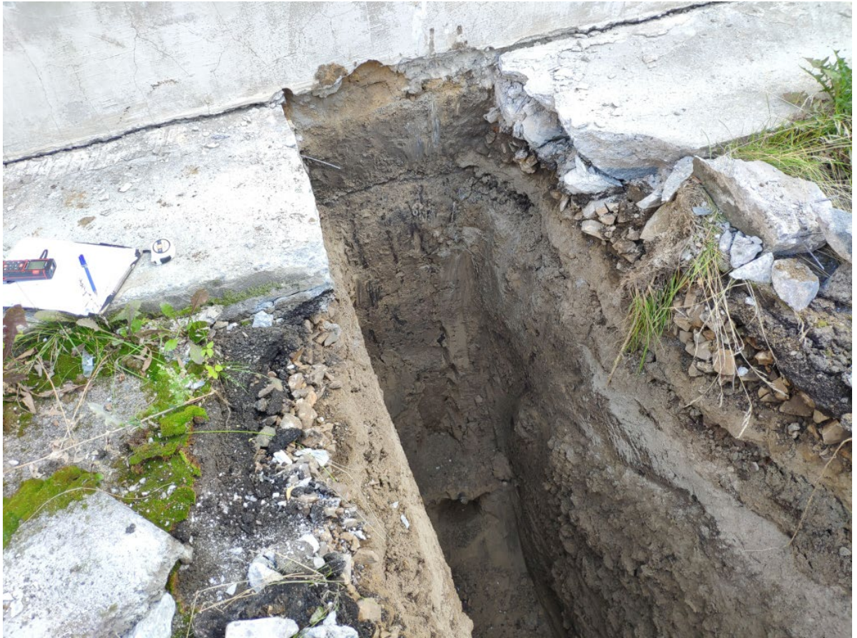
Фото 149. Контрольное вскрытие конструкций фундаментов (шурфление) в осях 2/Д-Е
