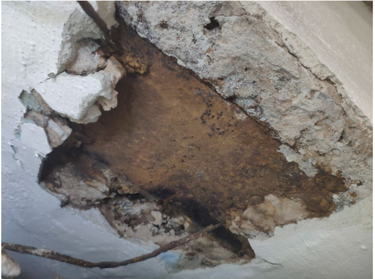
Фото 155. Контрольное вскрытие балки стального балочного перекрытия подвала в осях 5-7/Б-В
