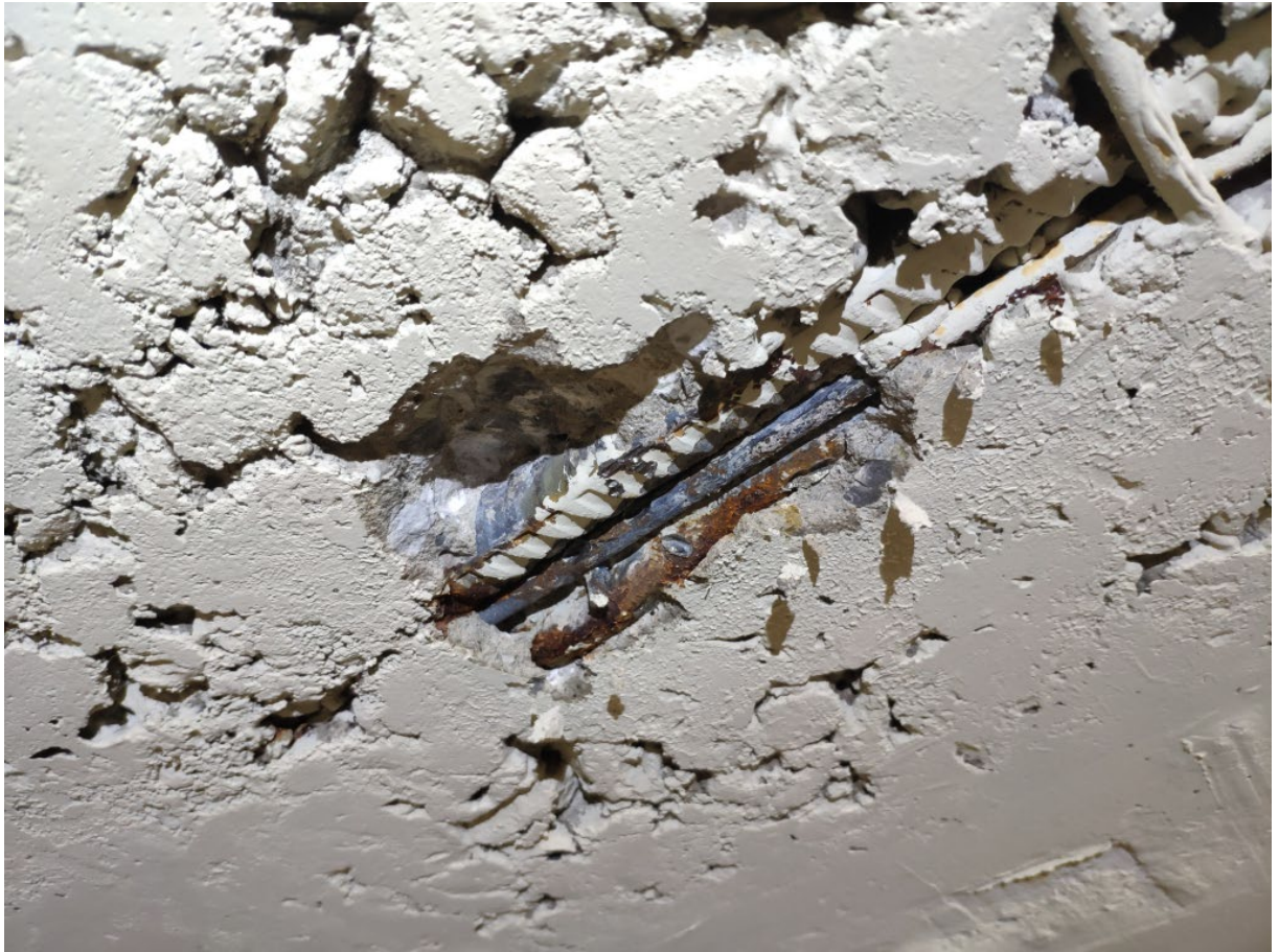
Фото 95. Контрольное вскрытие системы рабочего армирования многопустотных плит перекрытия и покрытия в осях 2-10/Б-Д
