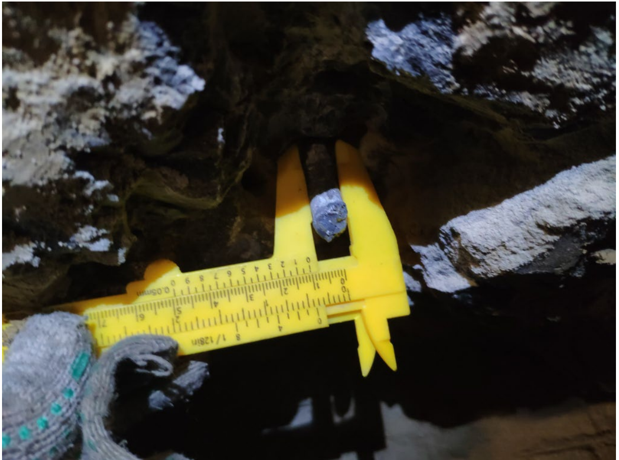
Фото 144. Контрольное вскрытие системы рабочего армирования фундаментов в осях 8-9/В
