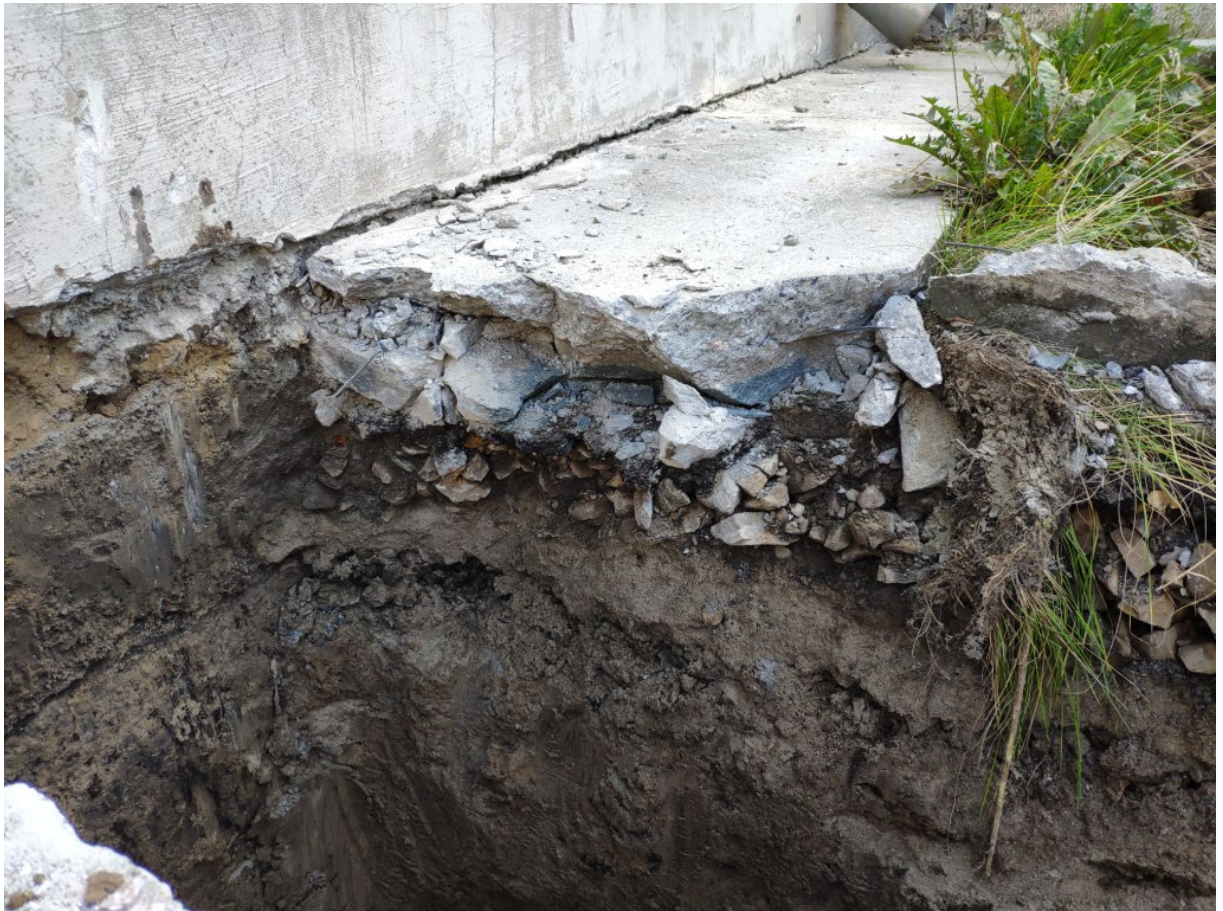
Фото 14.8. Конструкция отмостки в осях 2/Г-Е. Общий вид
