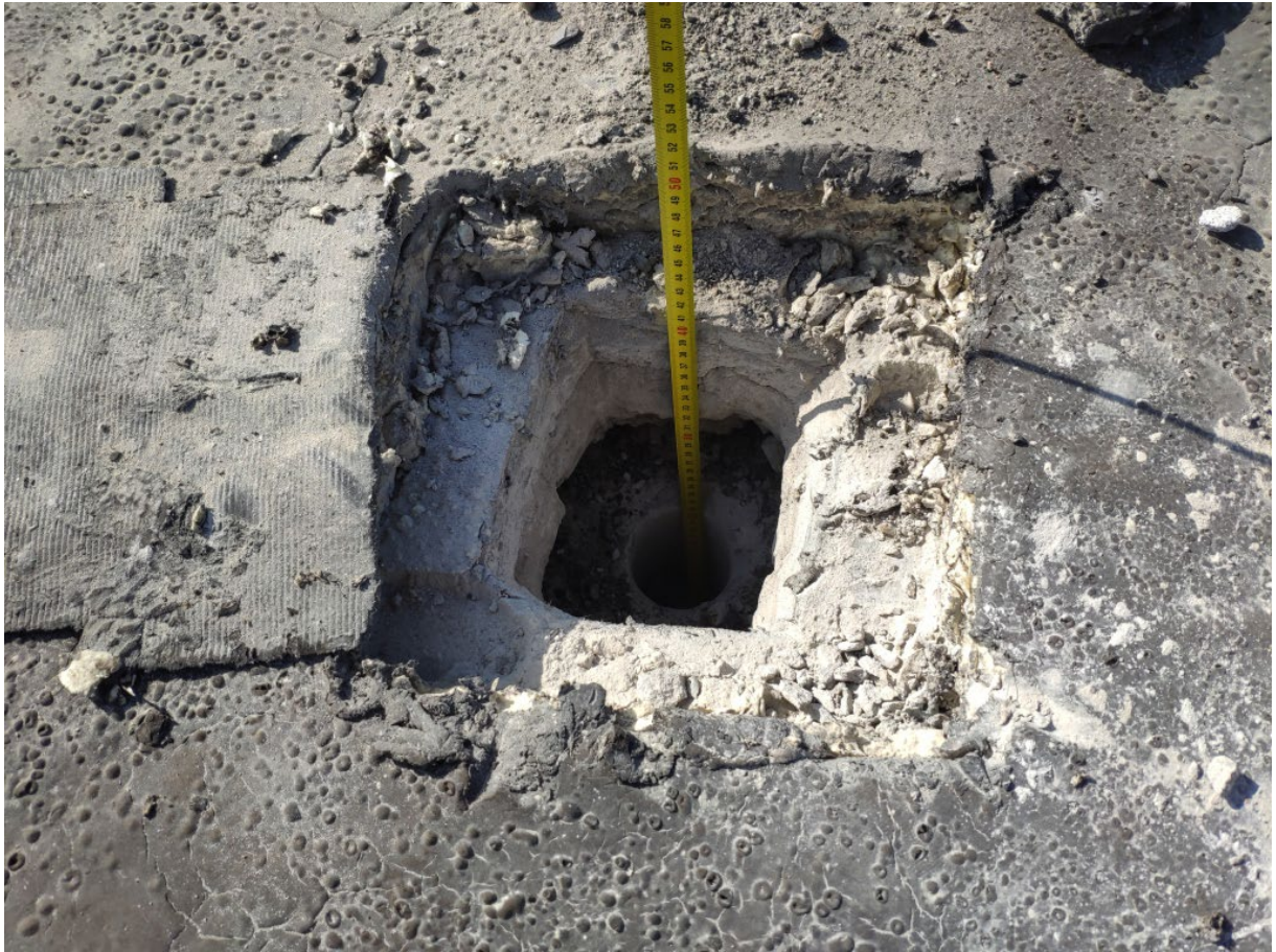
Фото 145. Контрольное вскрытие конструкций кровли №5.3 в осях 9-10/Г-Д
